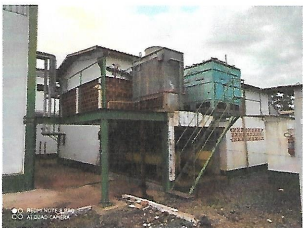
Foto 40 – Sala de Produtos Químicos
