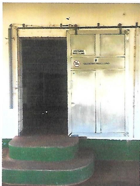
Foto 30 – Entrada do Vestiário Masculino
