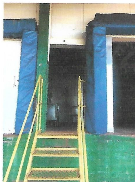
Foto 02 – Entrada de Serviço de Miúdos
