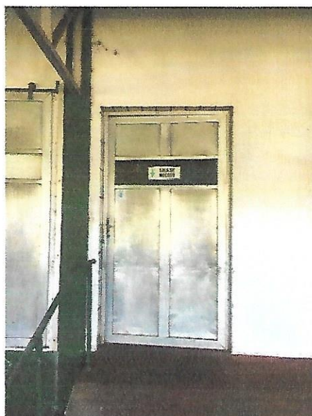
Foto 25 – Entrada do Setor de Mocotó
