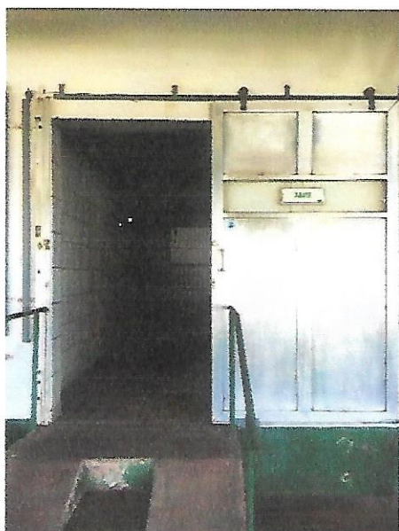
Foto 41 – Entrada do Abatedouro
