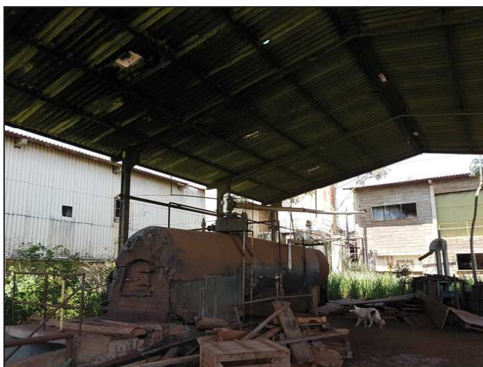
Caldeira – Vista interna.
