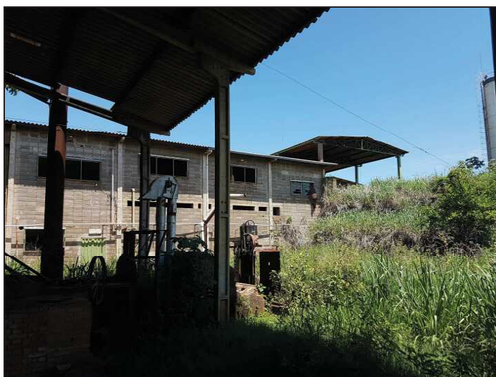
Processo – Vista lateral.
