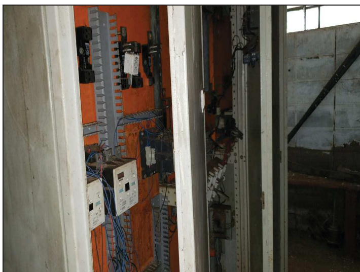
Instalação elétrica – Quadros elétricos.
