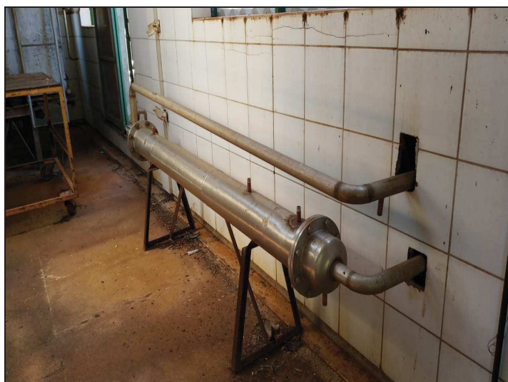
Produção – Trocador de calor casco-tubo.
