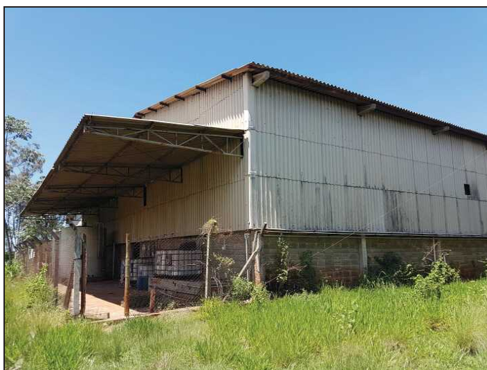
Ensaque e estoque – Fachada posterior.
