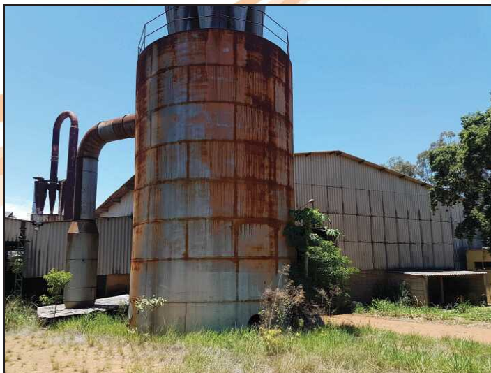
Ensaque e estoque – Fachada principal.
