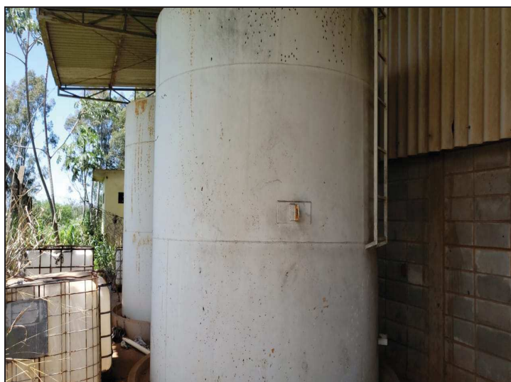
Envase – Tanques metálicos 10 m 3 .
