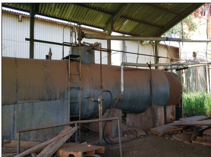
Geração de vapor – Caldeira 6.000 kgv/h.
