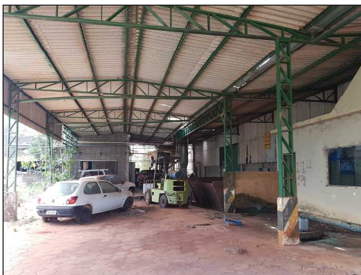
Ensaque e estoque – Cobertura anexa.
