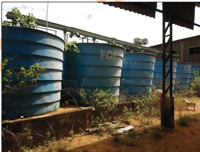
Reservatórios de água.
