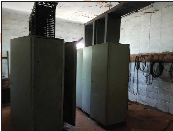
Processo – Pav. Térreo – Sala de comando.
