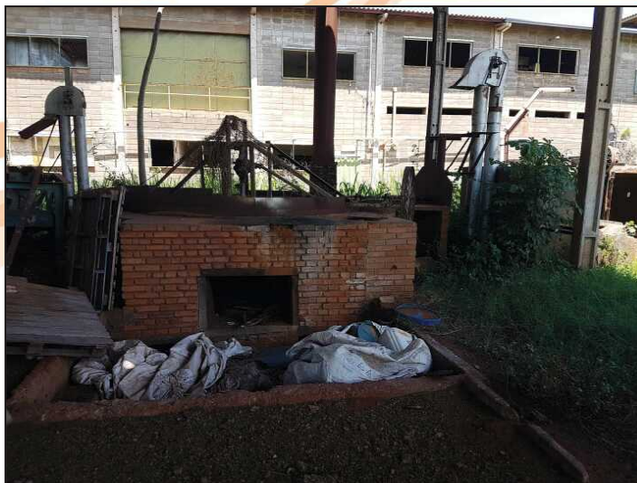
Caldeira – Vista interna.
