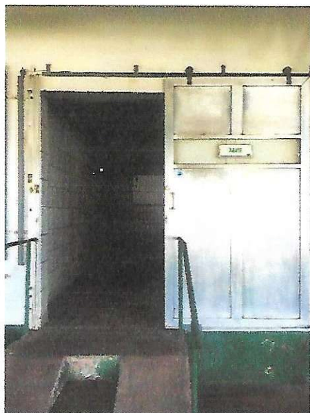
Foto 41 – Entrada do Abatedouro
