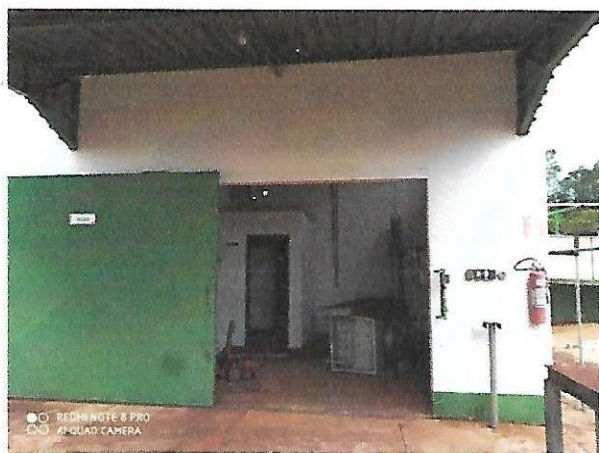
Foto 33 – Sala de Manutenção
