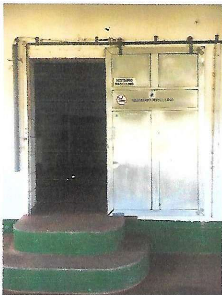
Foto 30– Entrada do Vestiário Masculino
