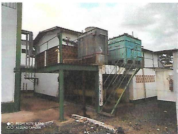
Foto 40 – Sala de Produtos Químicos
