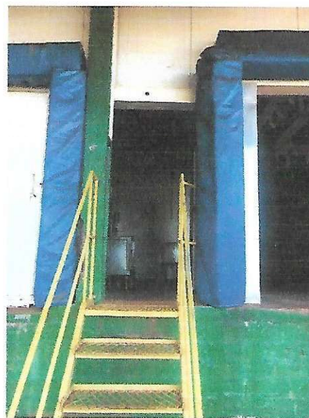
Foto 02 – Entrada de Serviço de Miúdos
