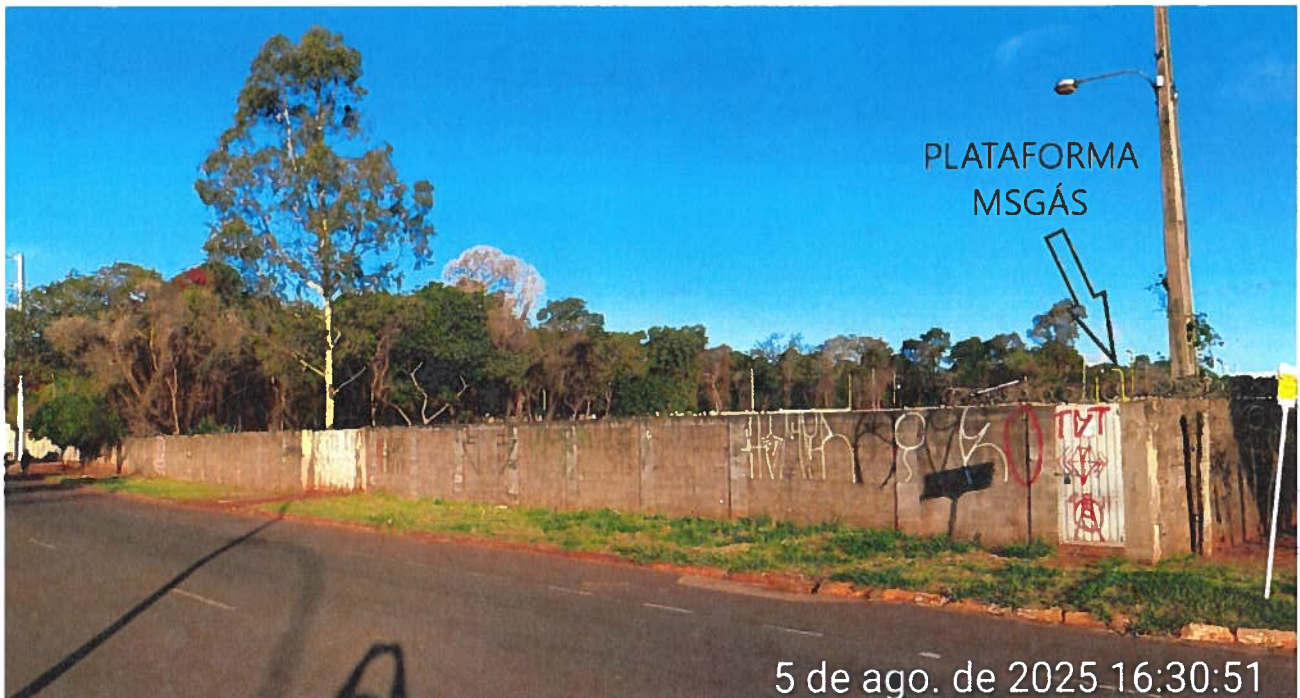
FOTO 04 – VISTA PELA AVENIDA FRIDA PUXIAN – LOTEAMENTO FECHADO POR MURO DE ALVENARIA.
