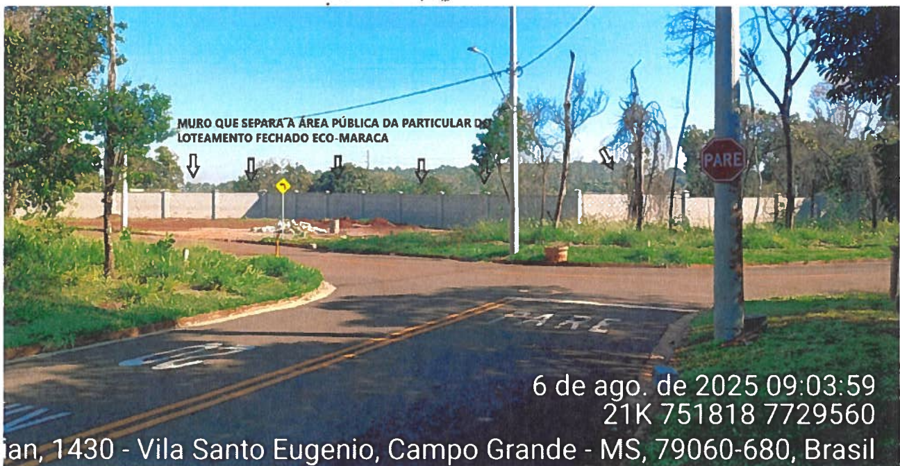
FOTO 07 – VISTA DO MURO PELA RUA INTERNA DO CONDOMÍNIO FECHADO ECO-MARACA.
