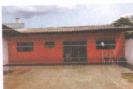
FACHADA ÁREA FUNDOS
